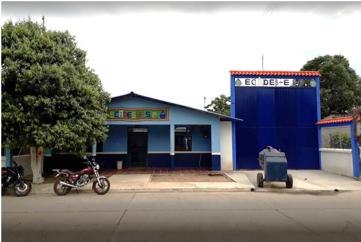
Fotografía 1 Centro de operación de ECADES ESP
