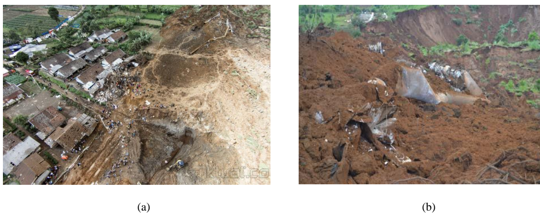
Gambar 4. Bencana longsor yang terjadi di Desa Margamukti, Kecamatan Pangalengan, Kabupaten Bandung, (a) menerangkan tentang bencana longsor yang merusak permukiman penduduk desa, (b) menerangkan tentang bencana longsor yang merusak infrastruktur pipa geothermal [9].
