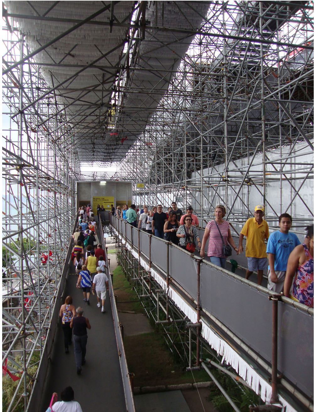
Figura 03 Rampas de acesso ao conjunto – elaboração Adriana Sansão
