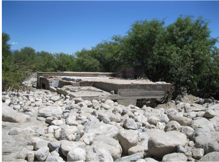
Foto 3: Casa ubicada sobre el cauce del río Siján.
