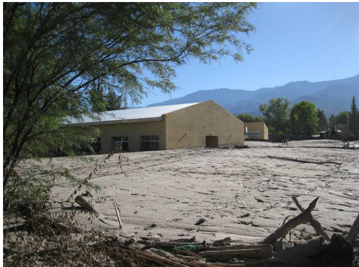
Foto 4: Escuela rellena y tapada por material del flujo en la localidad de Siján.
