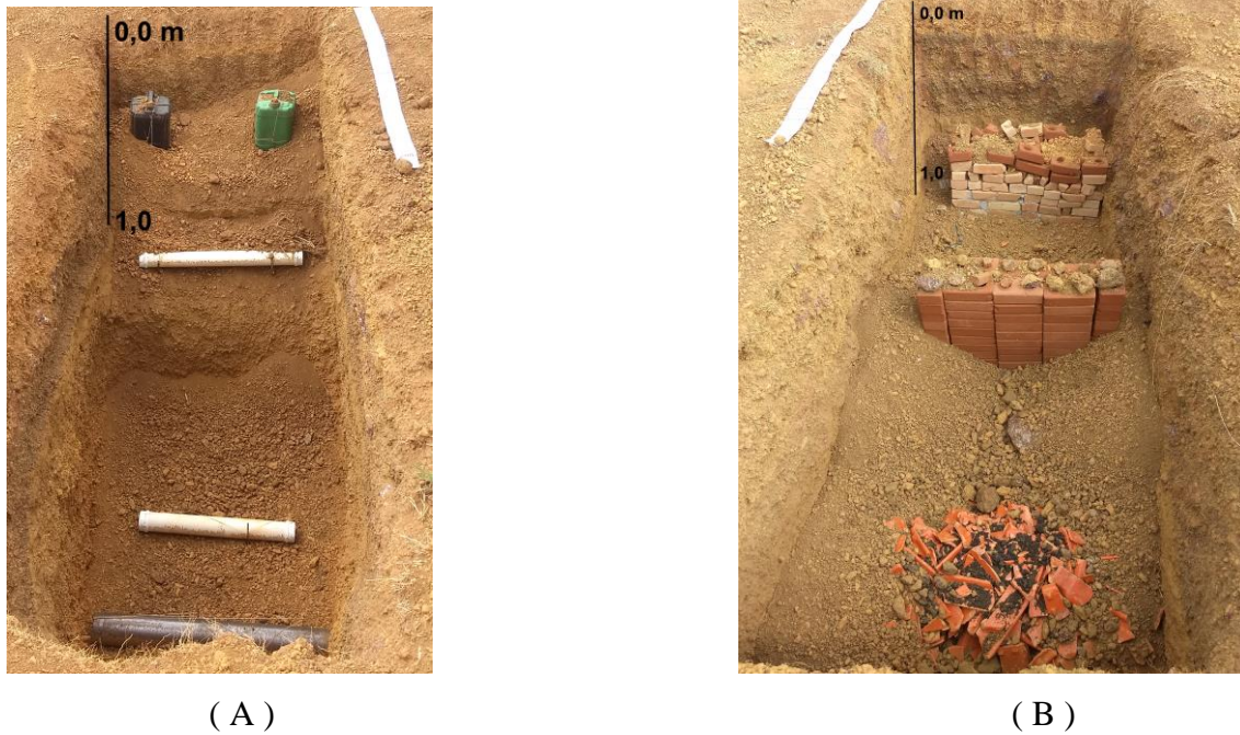
Figura 8 – Aspectos dos alvos dispostos nas trincheiras 04 A e B, em diferentes profundidades na área do SCGRA-ENG da UEG/CCET.
