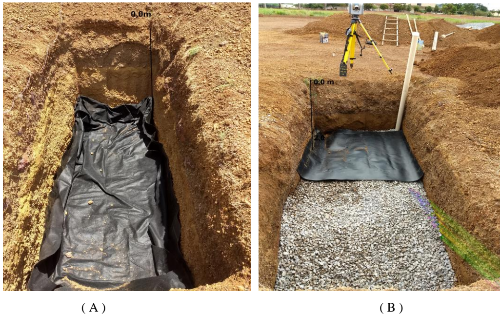
Figura 6 – Aspectos nas trincheiras, alvos dispostos nas trincheiras 03 A (base do pavimento) e B (parte intermediária do pavimento), em diferentes profundidades na área do SCGRA-ENG da UEG/CCET.
