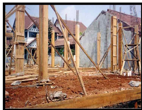
Gambar 1. Bekisting Konvensional
