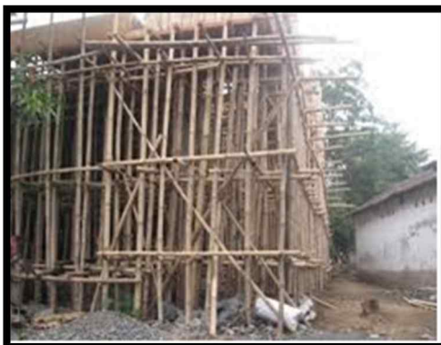
Gambar 1. Bekisting Konvensional
