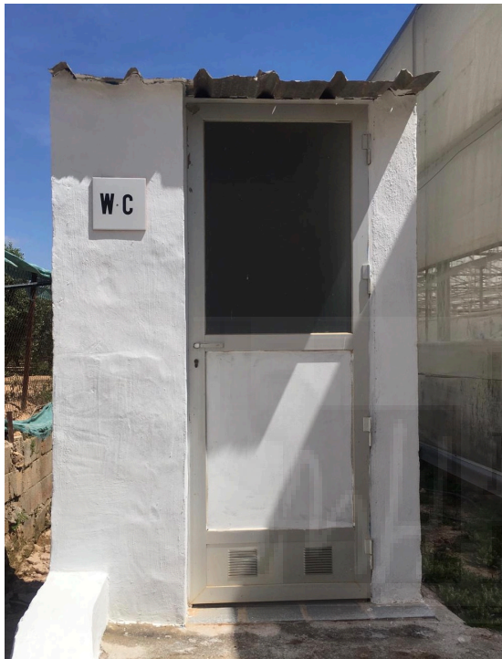
Fotografía 9: Aseo para personal
