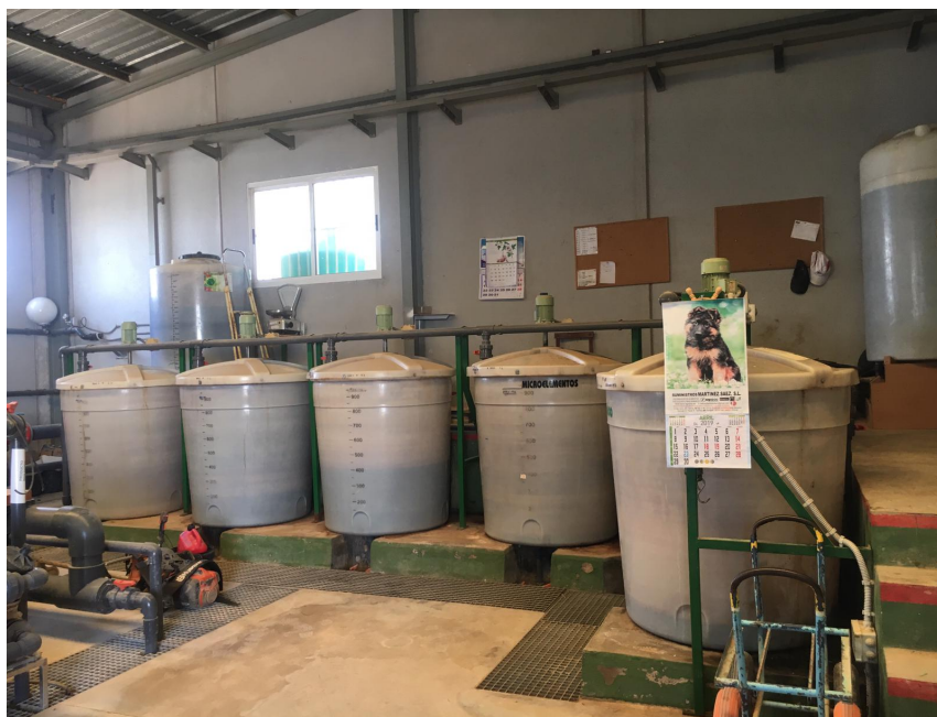
Fotografía 7: Tanques de productos de abono y su acceso
