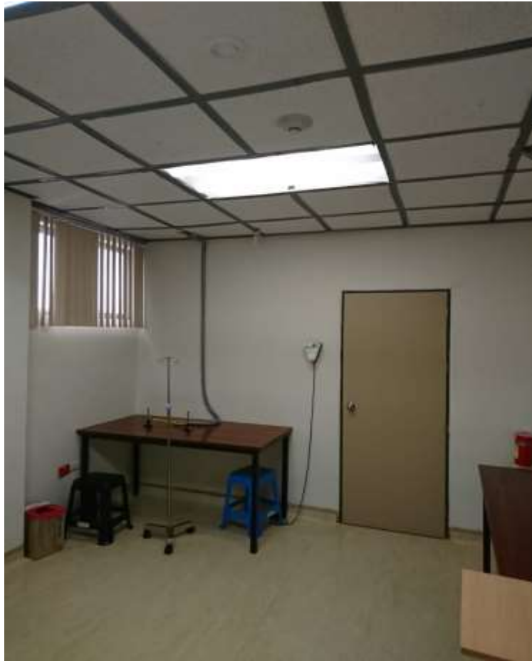
Fotografía 1-3: Zona actual de Farmacia donde se implementará el diseño del área de farmacotecnia.
