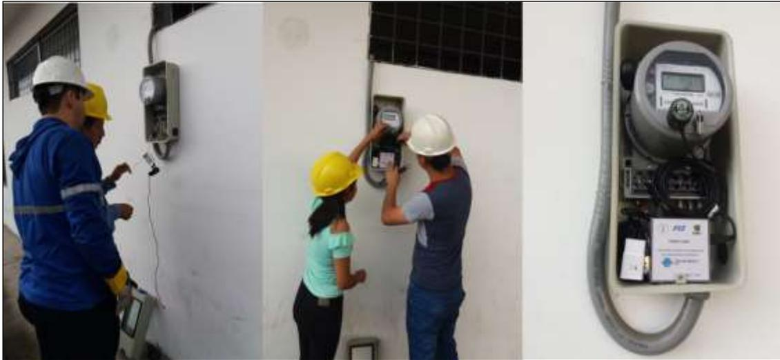
**Figura 3-3:** Instalación del nodo GPRS.
