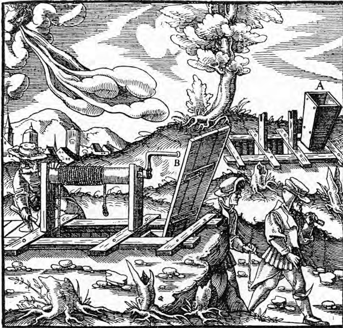
Abb. 2 Beispiel für bergmännische Bewetterung mit Lutten in einem Schacht. Holzschnitt 1556.
