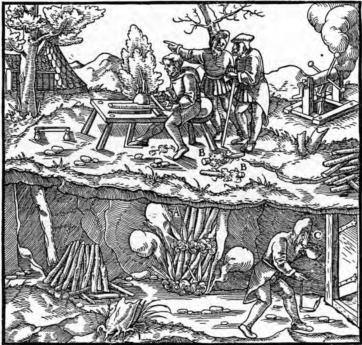
Abb. 1 Beispiel für bergmännisches Feuersetzen in einem Stollen beim Erzabbau. Holzschnitt 1556.
