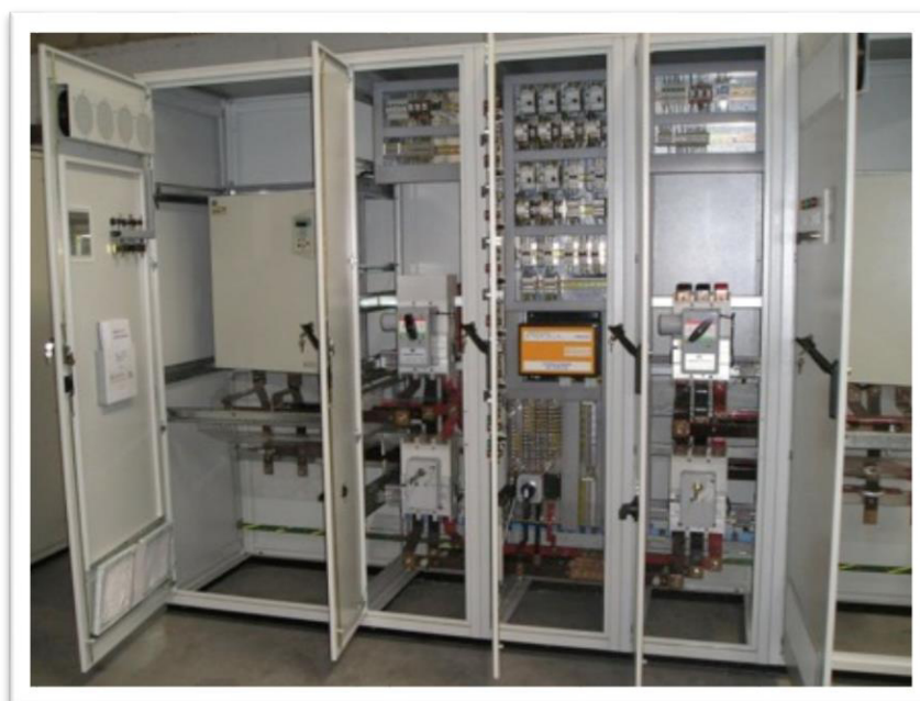
Figura 18: Ejemplo de Tablero de control y medición para subestación eléctrica.
