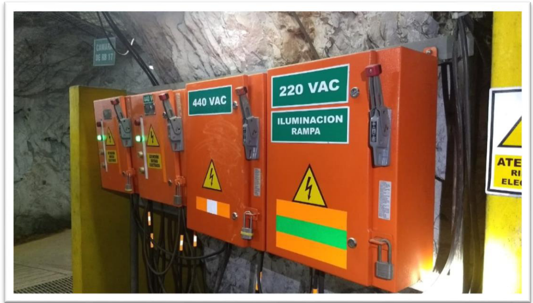
Fuente: Imágenes de los trabajos desarrollado en la sub estación.
