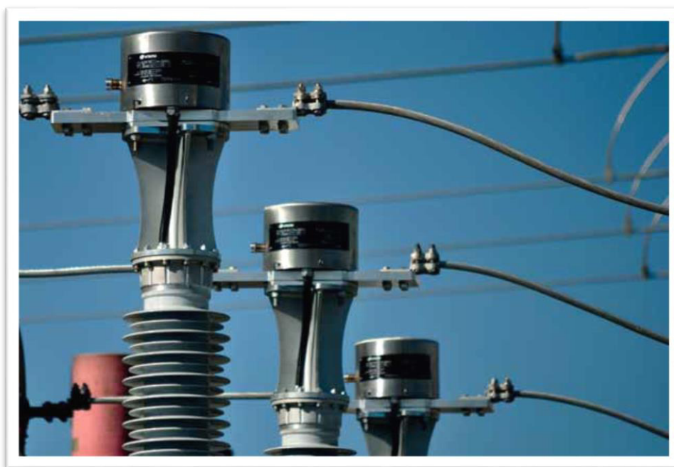
Figura 17: Ejemplo de Transformadores de potencial para subestación eléctrica.
