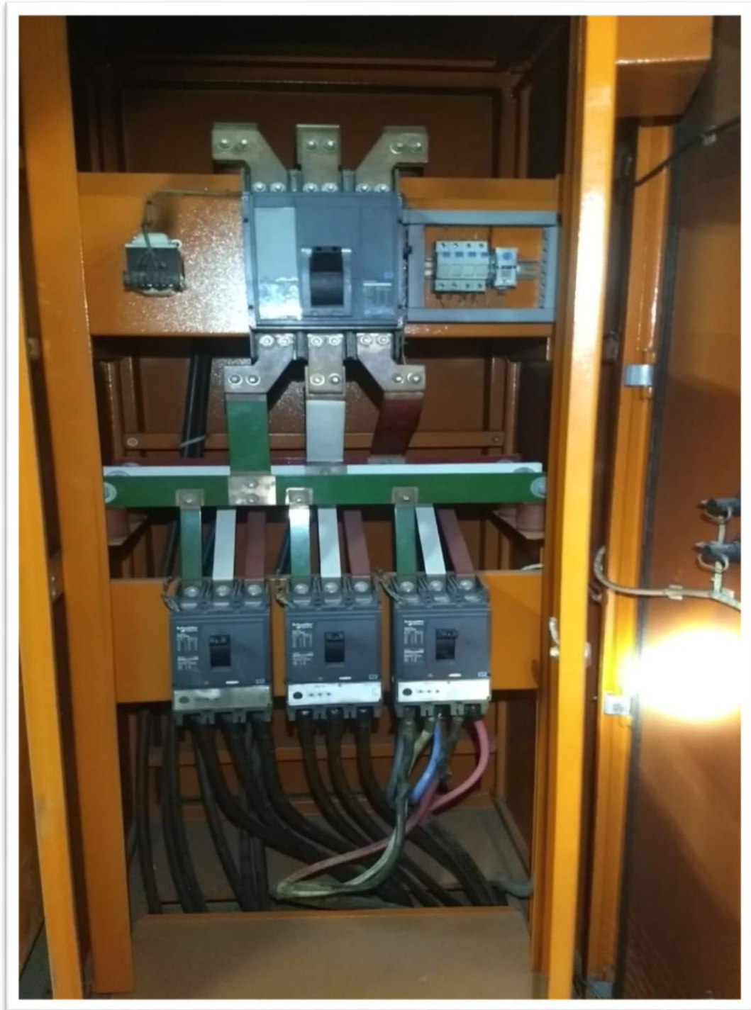
Fuente: Imágenes de los trabajos desarrollado en la sub estación.
