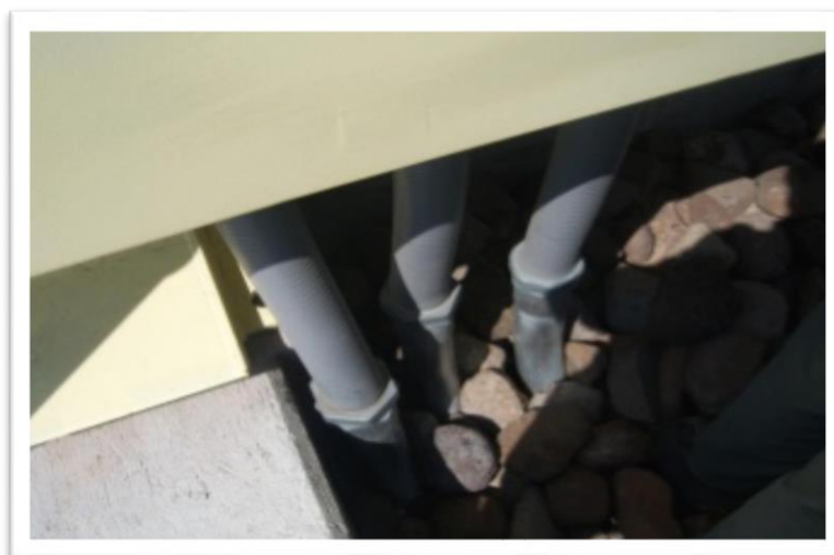
Figura 21: Ejemplo de fosa en una subestación eléctrica.
