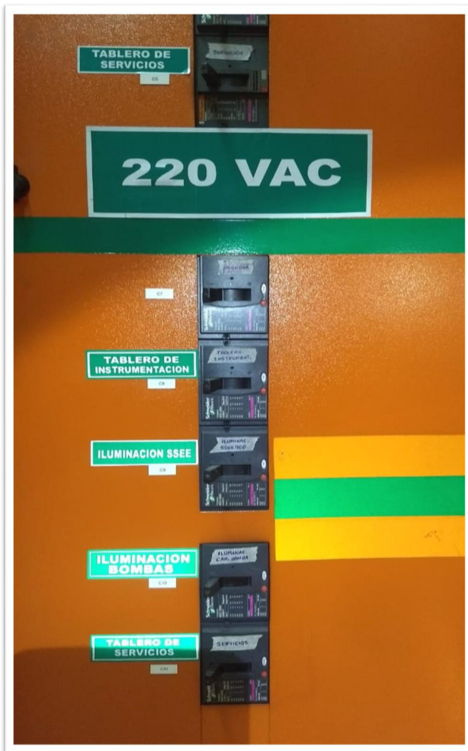
Fuente: Imágenes de los trabajos desarrollado en la sub estación.
