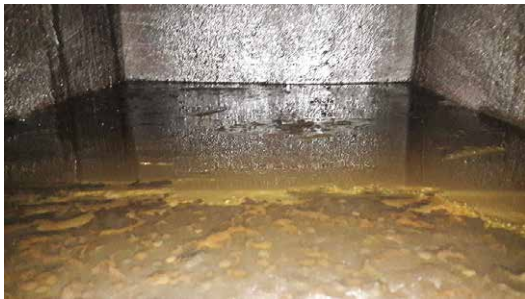
Bild 5.5. En ventilator på luftutslagningskanalen kan förbättra inneluftens kvalitet (uppe till vänster). En tilltäppt värmväxlare är ett exempel på försummade serviceåtgärder (uppe till höger). Fett på botten av en frånluftskanal från köket ökar risken för eldsvåda (nere till höger). En renat värmväxlare (nere till höger).
