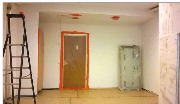
Bild 3.12. Skydd är en väsentlig del av dammhanteringen. Om man använder tejp ska man kontrollera varje dag att den inte lossnat. (Bild: Esko Sistonen)
