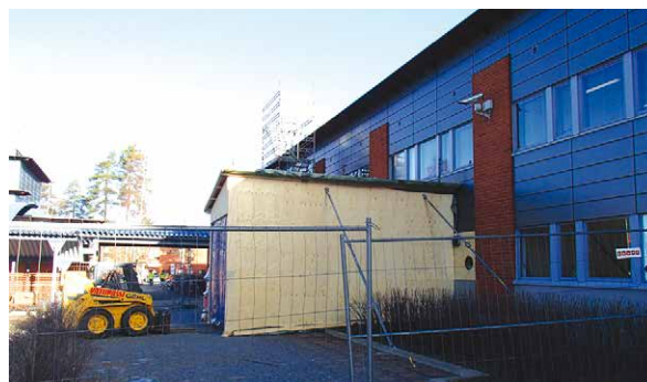
Bild 3.13. Utbyggnad av en avgränsande vägg till ett vindfång (uppe till vänster). Undertak som skyddats med en avgränsande vägg (uppe till höger). Kortvarig slussektionsvägg som försatts i undertryck vid reparation av ytterväggen, när den övriga delen av rummet är i normalt bruk och luften som går genom slussektionen filtreras innan det leds ut (nere till vänster). Vindfång/slussektion (nere till höger). (Foton: Mikko Kallinen, Sirate Ab)
