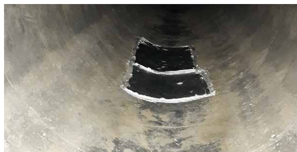
Bild 4.2. Exempel på behov av kvalitetssäkring: Igelkott och sand i en mycket smutsig tilluftskanal, måste avlägsnas innan ventilationskanalerna rengörs (uppe till vänster). Ovansidan av en kanal som inte rengjorts (uppe till höger). En rostig tilluftskanal före lappning (nere till vänster) och lappad, då det inte varit möjligt att byta ut kanalen (nere till höger).
