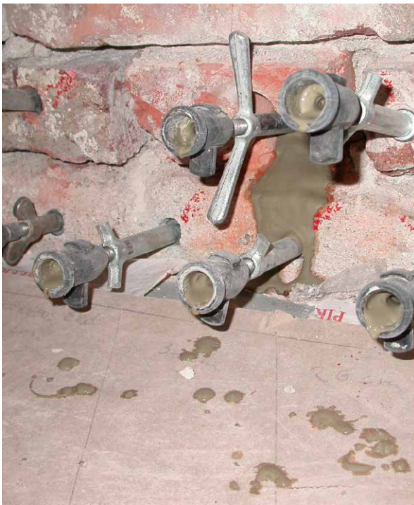
Bild 3.8. Kapillärbrytning som gjorts mekaniskt och genom injektering. (Foto: Tiina Palviainen, Vahanen Oy)
