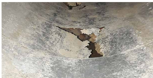
Bild 4.2. Exempel på behov av kvalitetssäkring: Igelkott och sand i en mycket smutsig tilluftskanal, måste avlägsnas innan ventilationskanalerna rengörs (uppe till vänster). Ovansidan av en kanal som inte rengjorts (uppe till höger). En rostig tilluftskanal före lappning (nere till vänster) och lappad, då det inte varit möjligt att byta ut kanalen (nere till höger).
