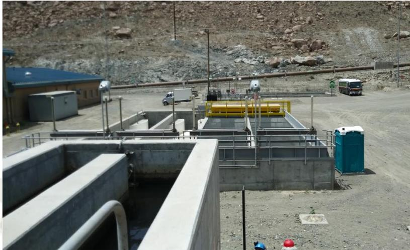
*Figura 9: Caja de derivación de efluentes y canal parshall*
