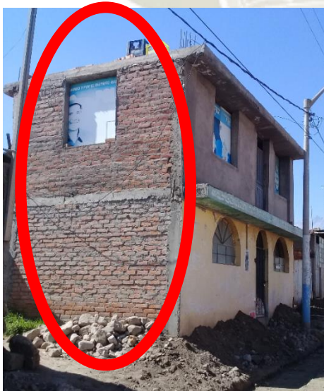
Figura N° 7.41: Vanos ubicados en muro portante Fuente: Elaboración propia
