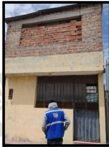
Figura N° 7.45: Vanos con una longitud mayor a la mitad de la longitud del muro. Elaboración Propia
