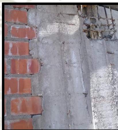
Figura N° 6.122: Columna vaciada con un Puntal de Madera Viviendas K-01 Pocsi Fuente Elaboración Propia
