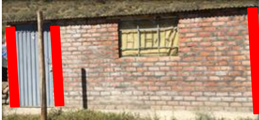
Figura N° 9.02: Inserción de columnas Fuente: Elaboración propia
