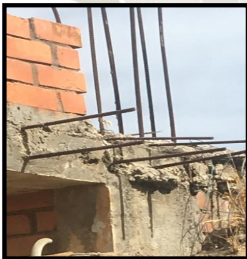
Figura N° 7.21: Aceros de columnas expuestos y en proceso de oxidación vivienda O 10 Piaca
