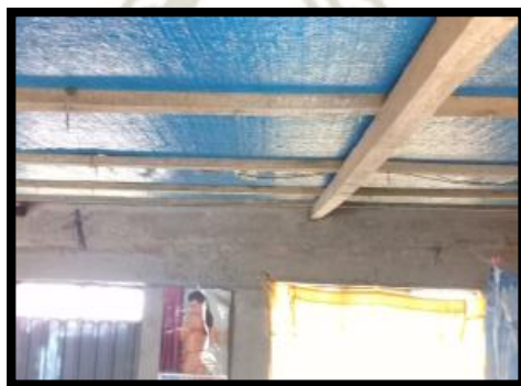
Figura N° 6.10: Vivienda con losa ligera (Calamina) L-02 Anexo Tuctumpaya Fuente: Elaboración Propia
