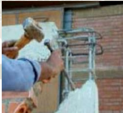
Figura N° 9.08: unión de viga columna Fuente: (MOSQUEIRA & TARQUEZ, 2005)
