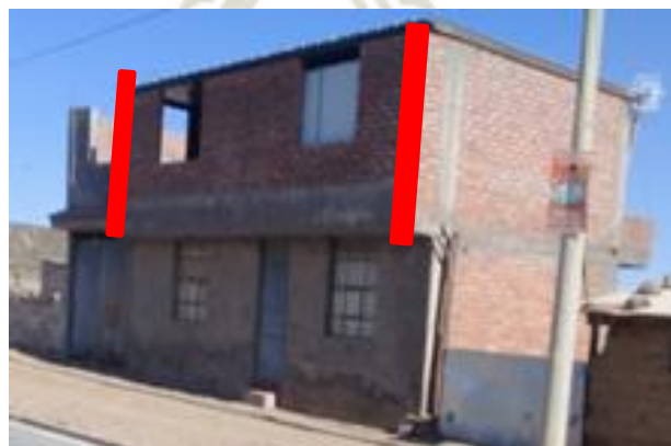
Figura N° 9.01: Inserción de columnas Fuente: Elaboración propia
