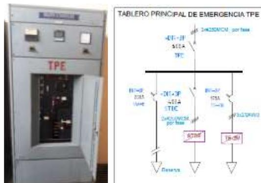
Fig. 20 a) Disposición física del tablero TPE; b) Diagrama unifilar del tablero TPE
