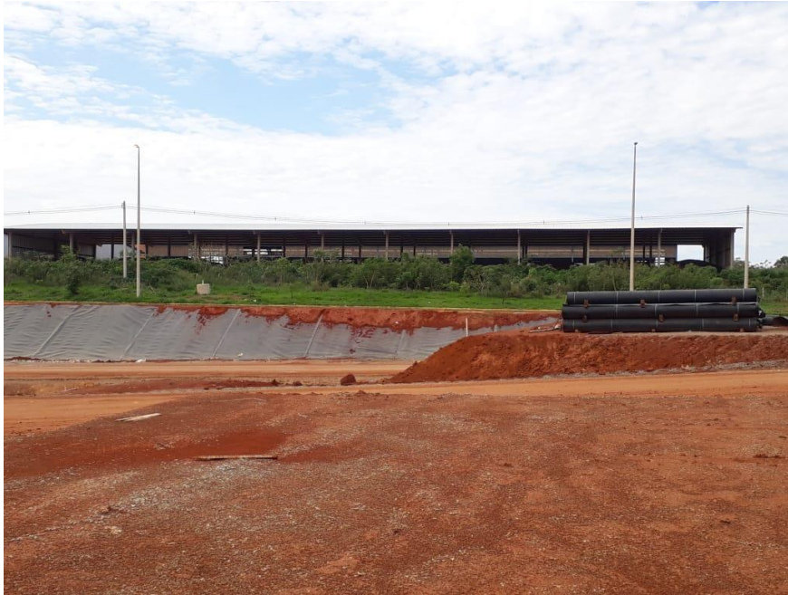
Figura 3.4 – Rolos de geomembrana e parte da manta de impermeabilização exposta. Fonte: Autora, 2018.
