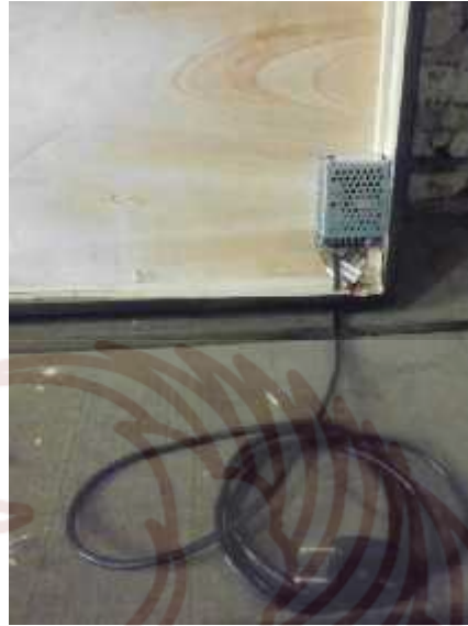
Gambar 34 Pemasangan adaptor dan kabel (Foto I Nyoman Suyasa)
