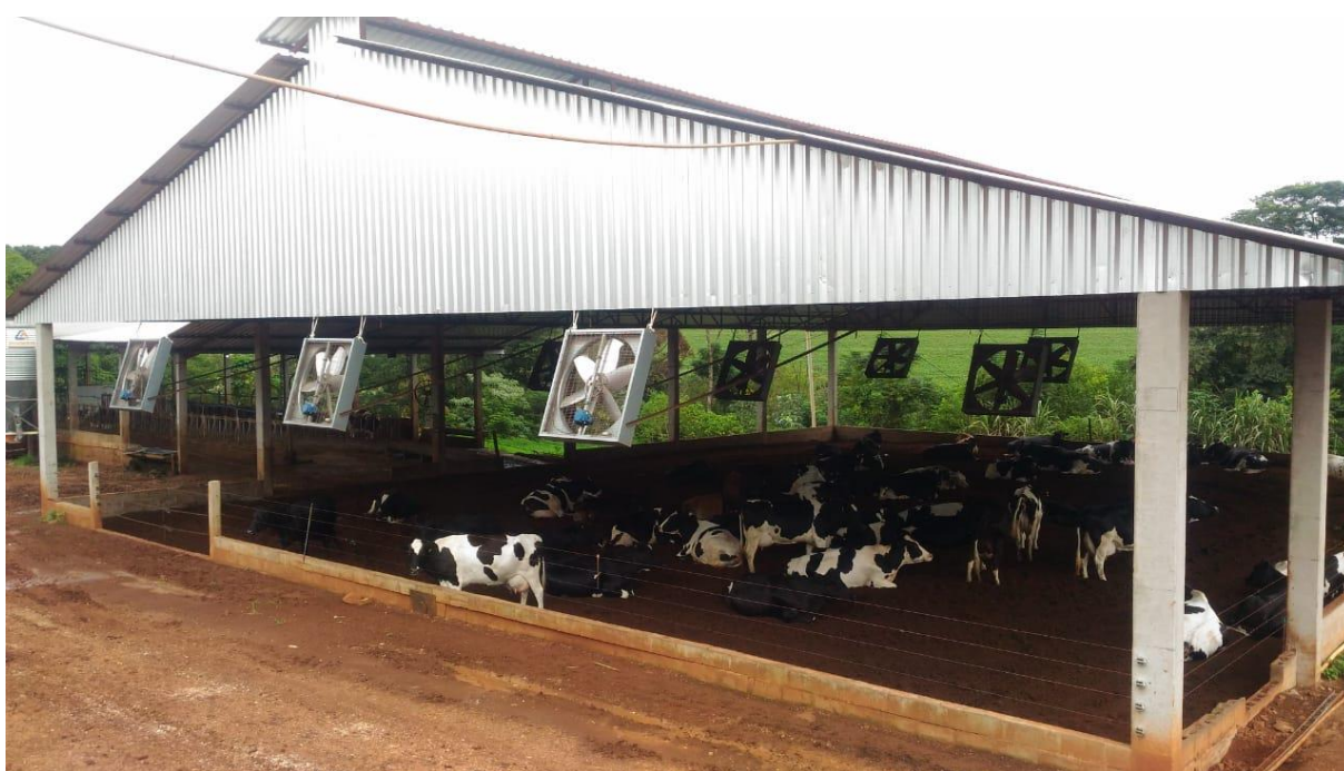
Figura 1 – Galpão compost barn Fonte: O Autor (2019)
