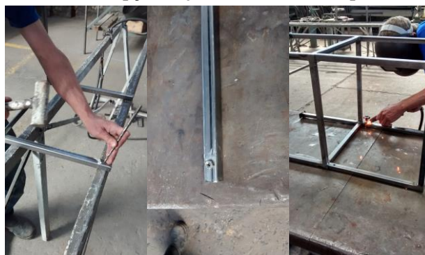
Figura 162 - Procedimentos de concepção e ajuste da estrutura superior sobre a estrutura inferior
