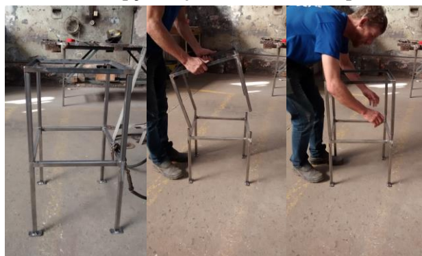
Figura 161 - Procedimentos de concepção e ajuste da estrutura superior sobre a estrutura inferior
