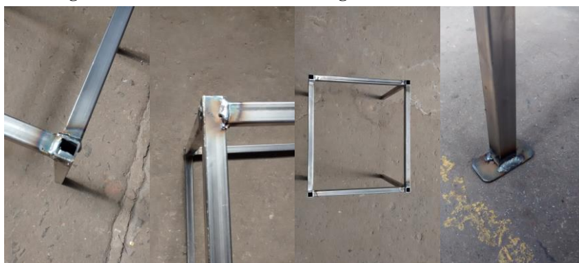
Figura 156 - Processo final de montagem da estrutura inferior
