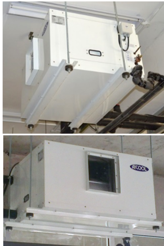
Fig. 2.8 Fan coil unit
