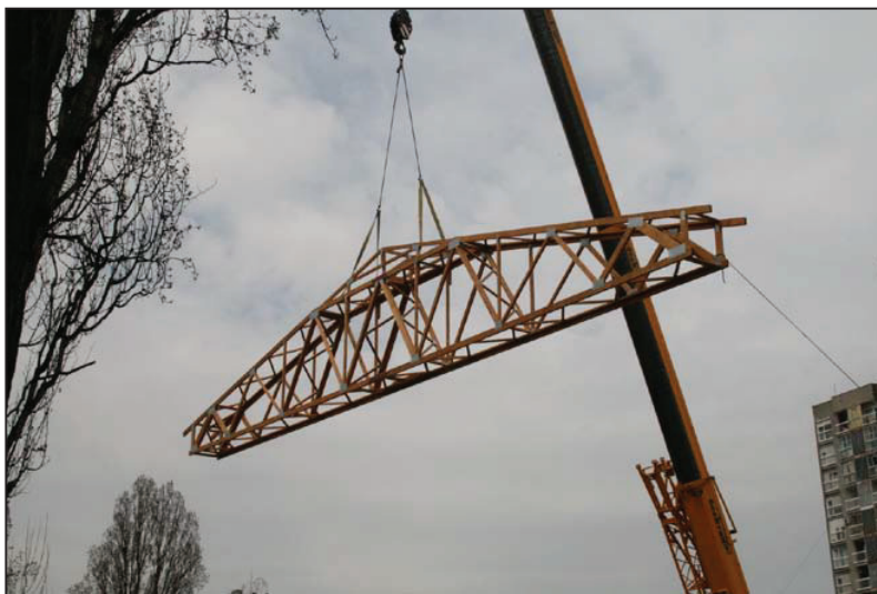
Slika 6. Montaža jednog paketa
