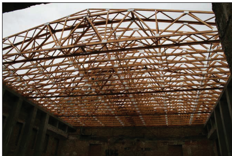
Slika 7. Formiranje krovne drvene strukture
