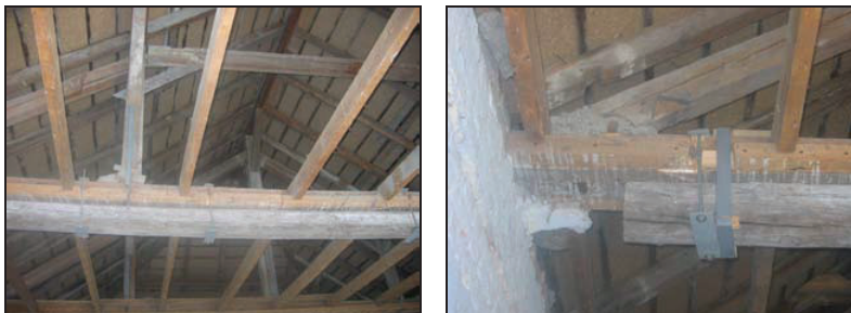
Slika 3. Krovni vezač u osi 3 - postojeće stanje
