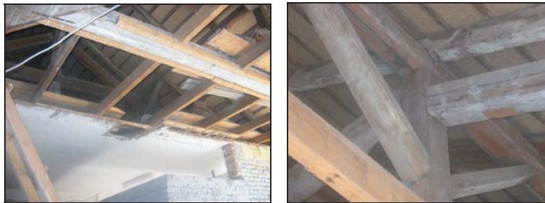
Slika 5. Krovni vezač u osi C - postojeće stanje
