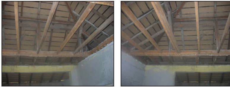
Slika 4. Krovni vezač u osi 5 - postojeće stanje
