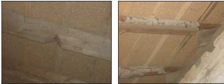
Slika 2. Drveni rogovi - postojeće stanje
