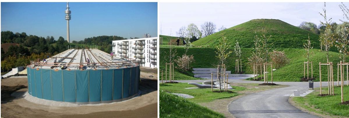
**Abb. 3-8** Behälterwärmespeicher mit 5 700 m<sup>3</sup> Wasservolumen aus vorgefertigten Betonelementen in München Ackermannbogen (im Bau und nach Fertigstellung)
