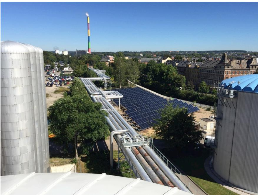
Abb. 3-5 **Solarthermie-Freilandanlage für die Wärmeversorgung Chemnitz Brühl (Foto: Eins Energie in Sachsen GmbH & Co. KG)**
