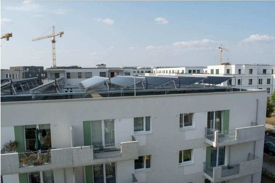
Abb. 3-4 **Aufdach-Installation von Solarthermie in der Quartiersversorgung Berlin-Adlershof (Foto: Guido Bröer)**
