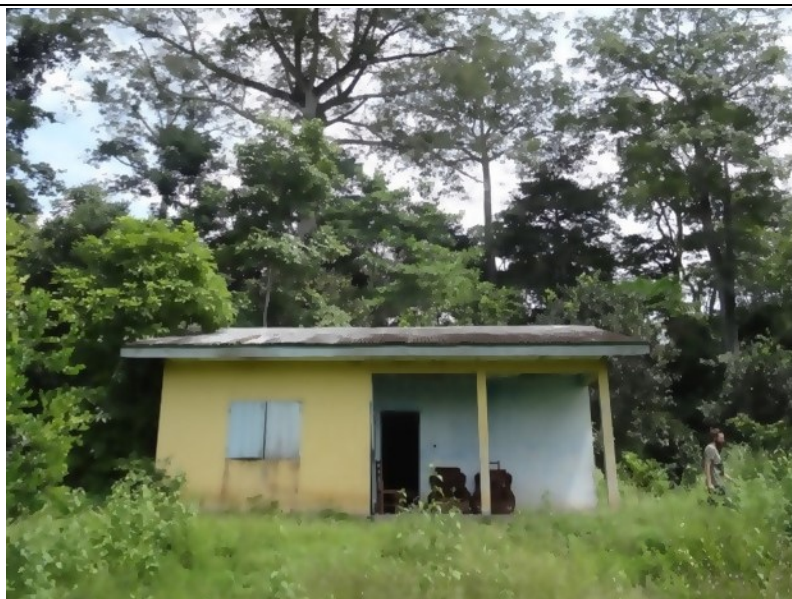
Image 8: Un bâtiment de bureau abandonné à Djembe
