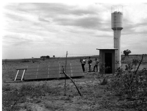
Figura 2. Sistema de bombeamento fotovoltaico em poço tubular.
