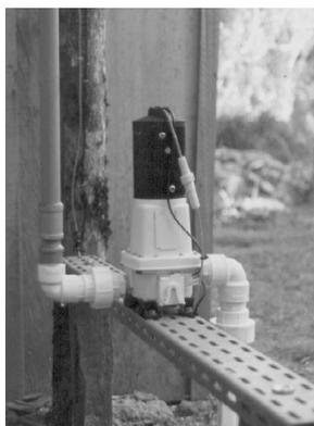
Figura 1. Sistema de bombeamento fotovoltaico de superfície.
