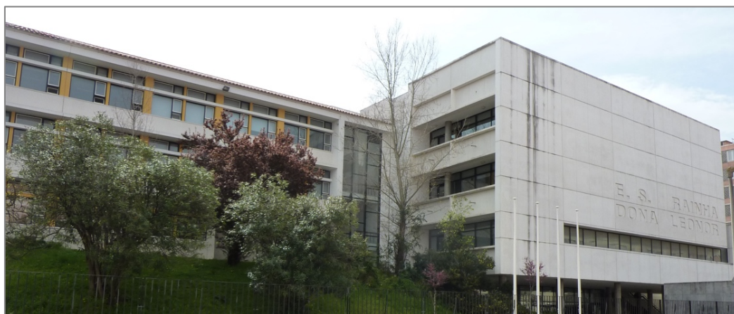
Fig. 3 – Fachada principal da ESRDL
