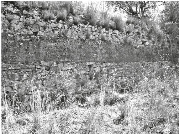
Fig. 4 – Exterior de um troço do aqueduto de *Conimbriga* assente em *subtracciones*
