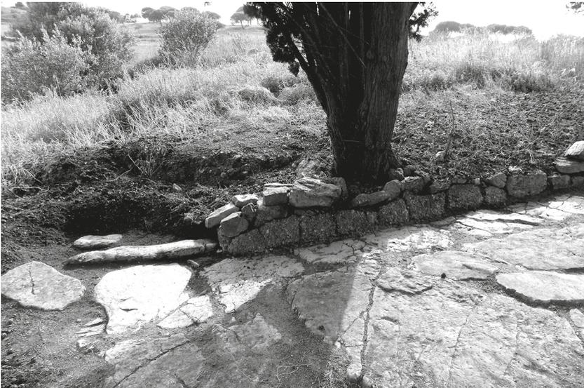
Fig. 14 – Estrutura de impermeabilização em *opus signinum* na Via III de *Mirobriga* (foto cedida por Catarina Felício).
