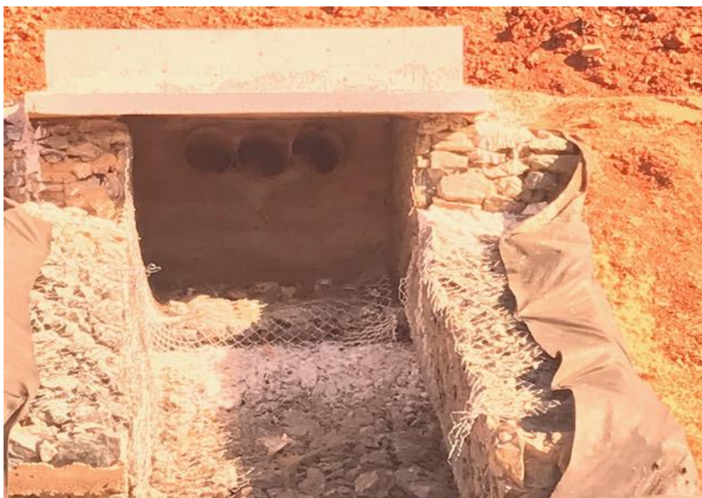
Figura 18 - Saída e caída do chorume.
