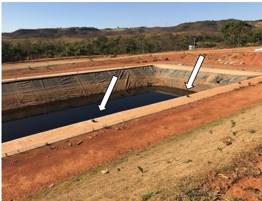
Figura 19 - Lagoa de chorume Aterro Sanitário de Brasília.
