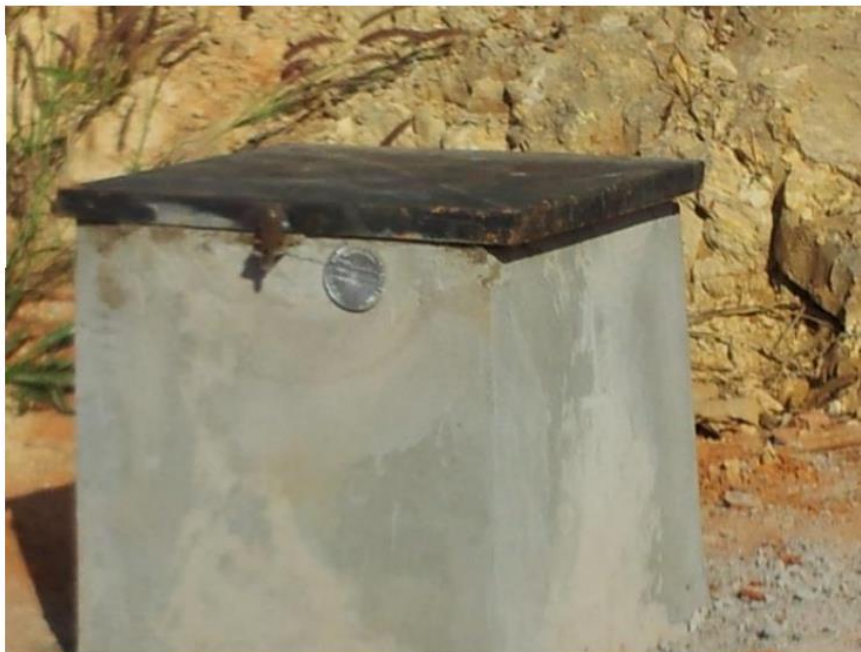
Figura 20 - Poço de monitoramento
