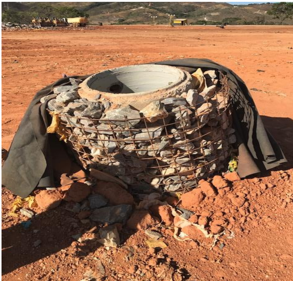
Figura 17 - Chaminé da combustão do gás metano.
