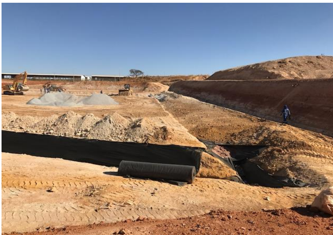
Figura 16 - Preparação do terreno para aterramento.
