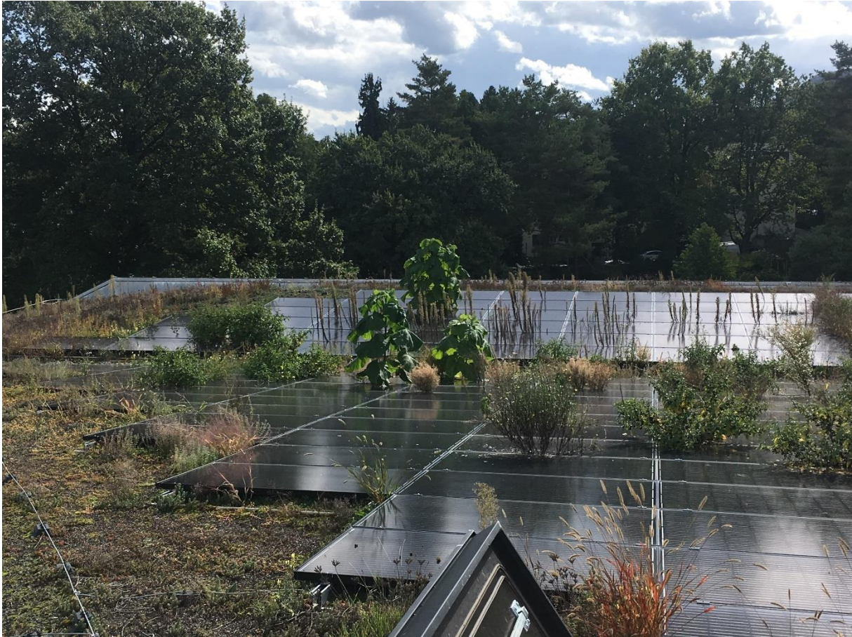
Abbildung 16: Photovoltaikanlage, bei welcher mehrere Libellen beobachtet wurden (Foto: Jascha J. van Gogh, 24.09.2019)
