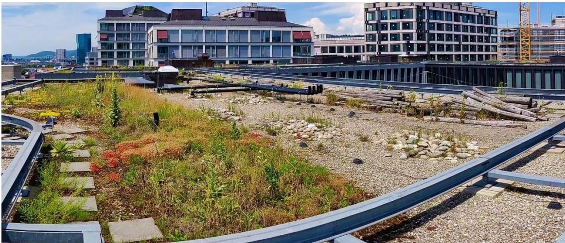
**Abb. 8:** Dachgestaltung des Baufeldes C mit offenen Flächen, Stellen dichten Bewuchs und Strukturelementen wie Holz- und Steinhaufen. (Quelle: eigenes Bild)
