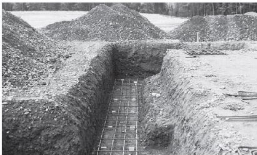
Figura 2.3.1 Cimentación superficial
