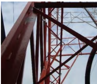
d) Columna de doble ángulo LI sección estrella
