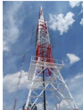
b) Torre autoportada
