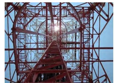
f) Torreta central y horizontales de ángulo LI
