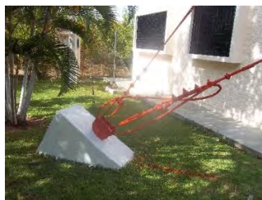
e) Dado de cimentación, ancla y retenidas
