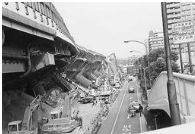
Figura 1. 3. Colapso de la autopista Hanshin Expressway durante el sismo de Kobe en 1995 (Foto: Yamanouchi Yasuo).
