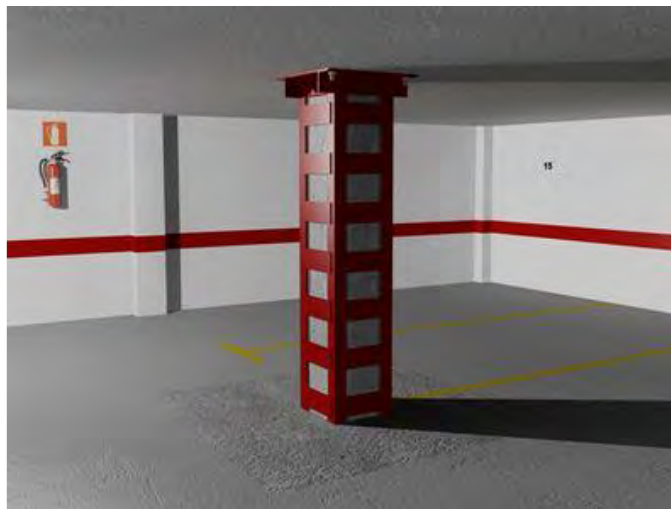
Figura 6. 5. Encamisado metálico en columnas, por medio de soleras se da el confinamiento y resistencia adecuados, cuando estas propiedades requieren ser bajas.
