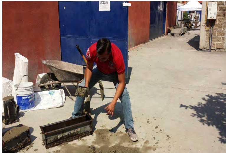
Figura 4-8. Vaciado de moldes.
