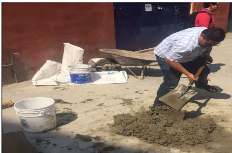
Figura 4-7. Elaboración de mezcla.
