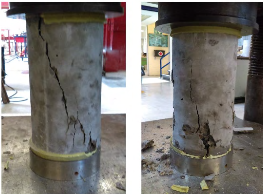
Figura 4-18. Tipo de falla en cilindros de concreto.
