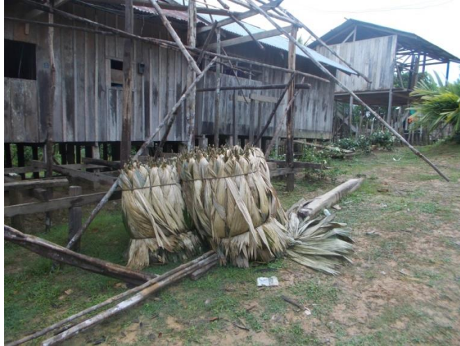
Imagen 10. Hojas de Mauritia flexuosa para la fabricación de un techo en San Juan del Socó, Resguardo Ticoya, Amazonas, 2017. Fuente: foto propia.
