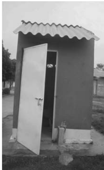
Figura 2. Caseta Estación de Bombeo
