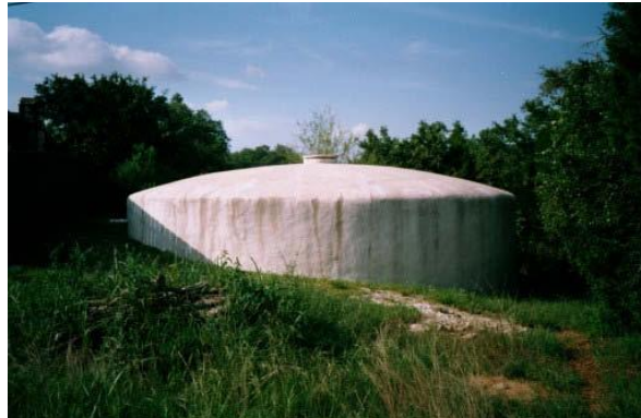
Figura 10. Tanque de almacenamiento semienterrado en ferro-cemento.
