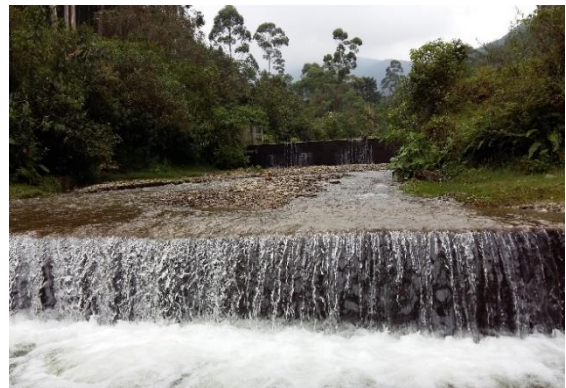
Foto 38. Segunda represa, parte baja Fuente: Registro trabajo de campo, 2015
