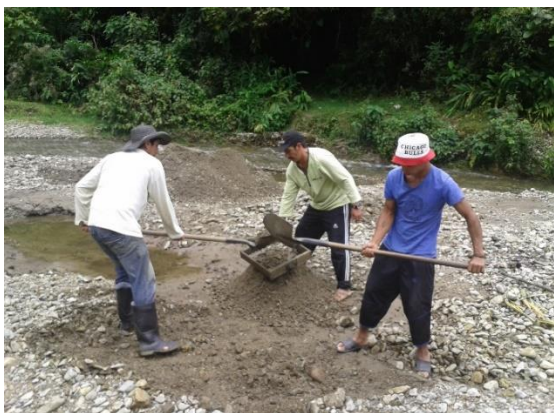
Foto 40. Extracción y ubicación de arena en la malla Fuente: Registro trabajo de campo, 2015
