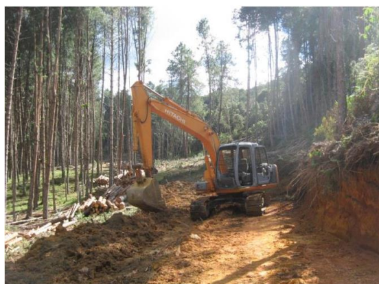
Foto 14. Construcción de vías forestales. Fuente: Resumen Público Plan de Manejo Forestal. Septiembre de 2013.
