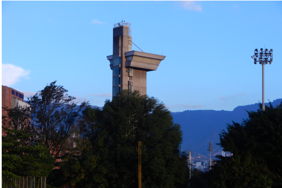
Figura 3-15.: Fotografía de la torre del Sistema de Alerta Temprana de Medellín (SIATA), en cuya terraza se ubican un ceilómetro y un radiómetro de micro-ondas, entre otros equipos.
