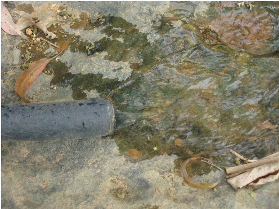
Foto 5. Detalle de la purga de los tanques.
