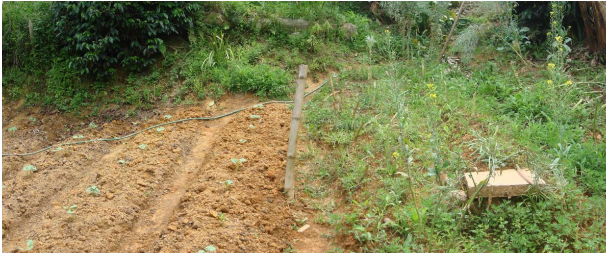
Foto 2. Zona destinada para el tanque séptico y con desarrollo de cultivos, la vara indica la posición del tanque.
