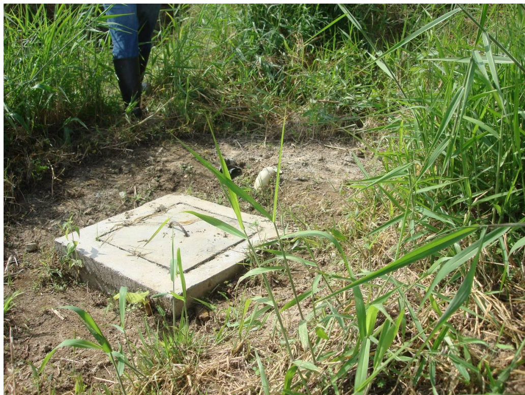
Foto 3. Panorámica de usuarios y uno de los tanques del sistema colectivo.
