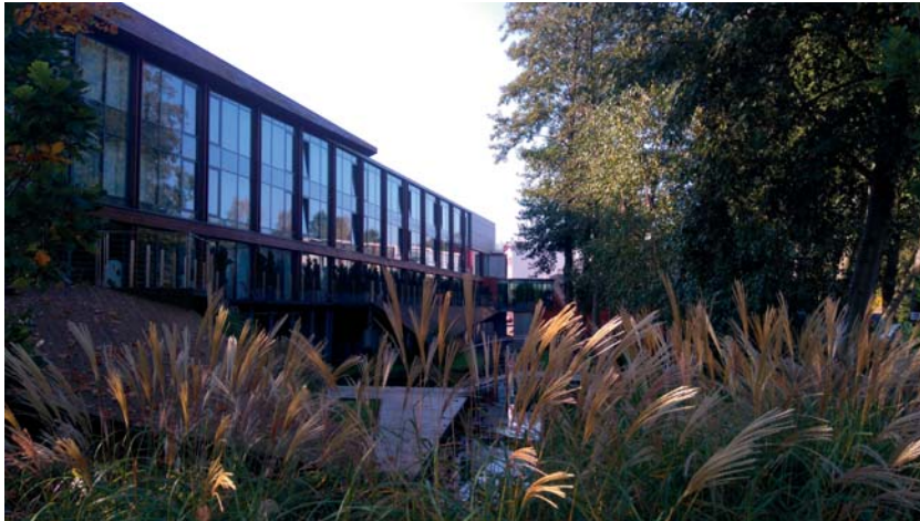
Fot. 5. Hotel Przystań, proj. Dżus GK Architekci. Fot. M.A. Urbańska.
