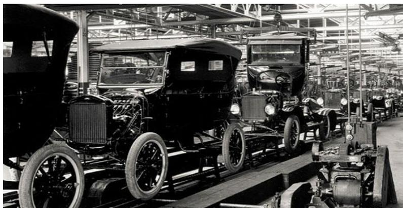
*Figura 2.2:* Cadena de montaje
