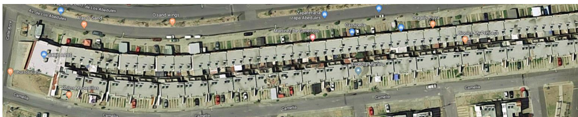
Ilustración 38: porción de manzana con departamentos dúplex en Los Abedules. Obtenido de Google Maps.
