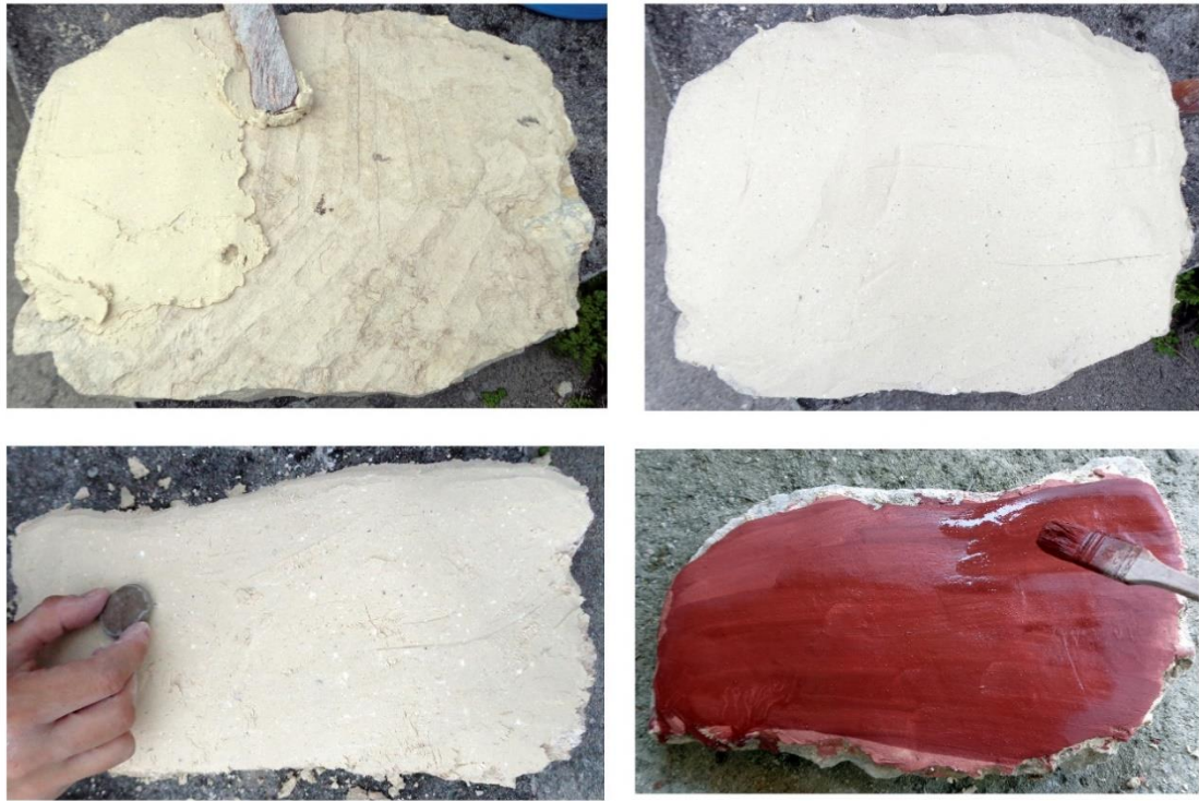
Figs. 4.25 a 4.28. Aplicación del mortero, fratasado y aplicación del pigmento.
