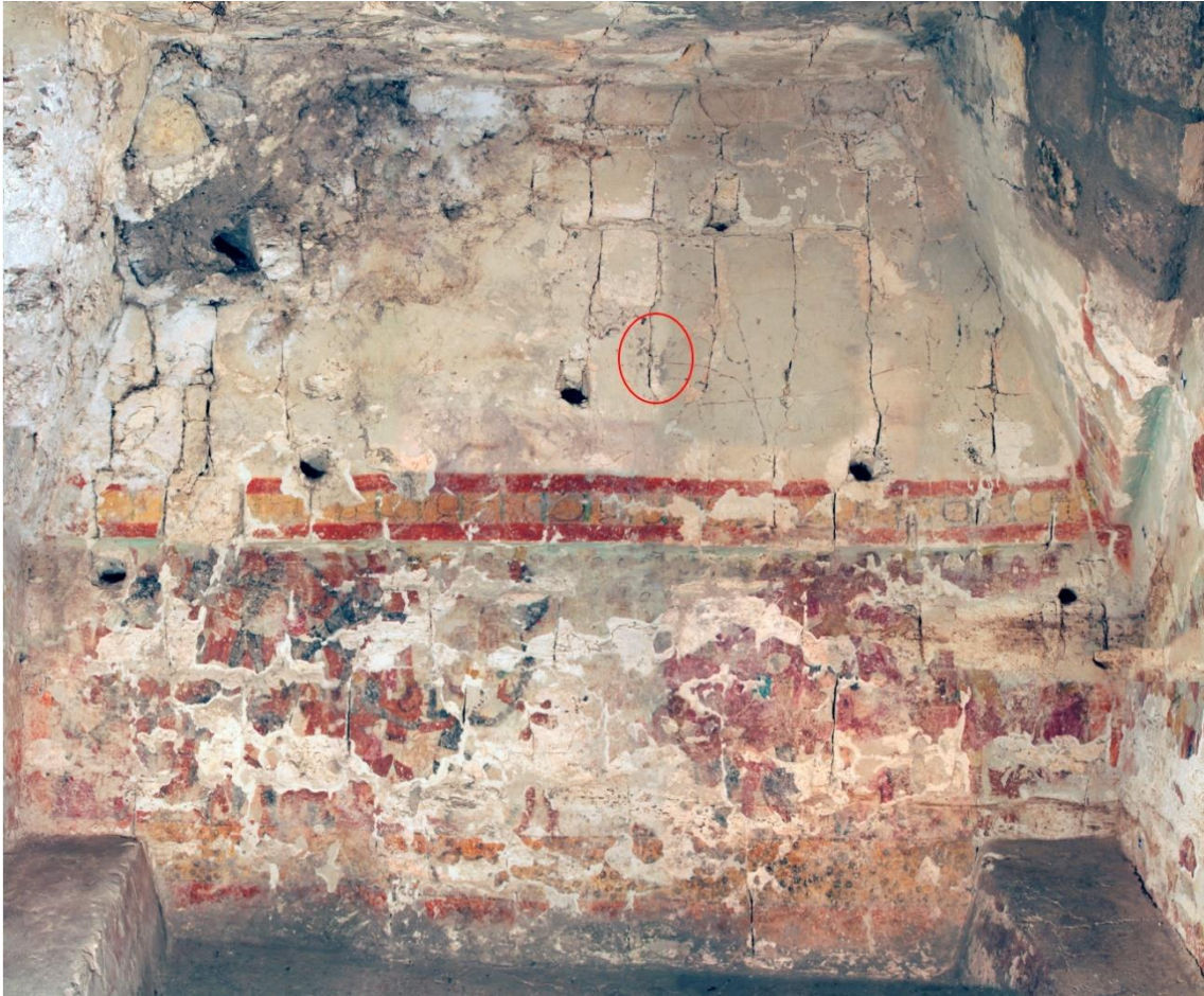
Fig. 5.112. Vista de la bóveda y el muro Oeste del “Cuarto de las Pinturas” de Chilonché. La ubicación de la huella de mano impresa en la bóveda está marcada con un círculo rojo.
