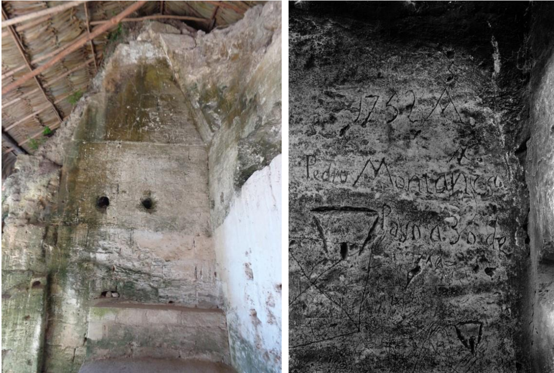
Figs. 4.5 y 4.6. Fotografía del muro oeste del Cuarto 4 de la Estructura 6J2 de La Blanca en la que se observa la línea de derrumbe y detalle de los grafitos incisos sobre ésta en 1913.
