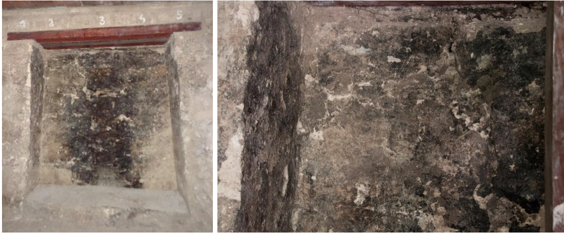
Figs.6.10 y 6.11. Fotografía de la hornacina y detalle del estuco calcinado registrado en su muro Este.
