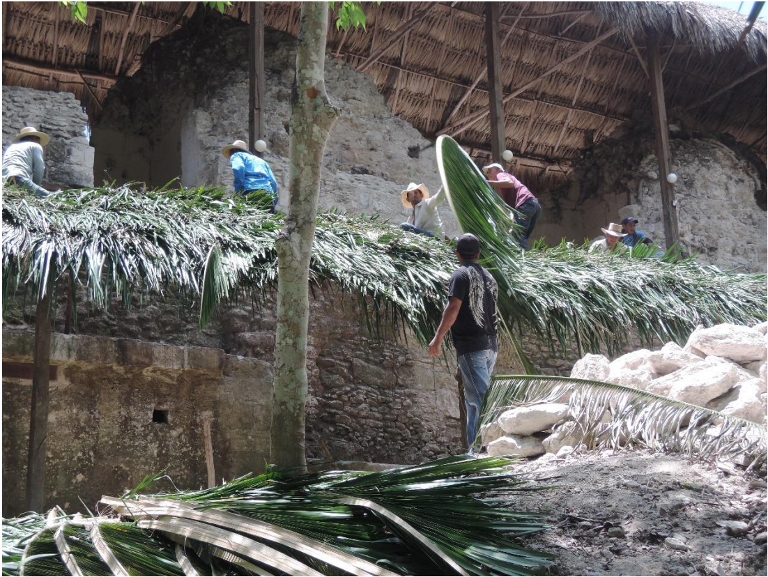
Figs. 3.201- 3. 204. Grafitos procedentes de La Blanca y Tikal (Lámina 128) y fotografía de la construcción de las cubiertas para la Subestructura de La Blanca en 2017.
