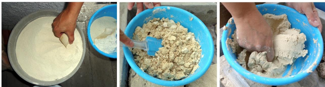
Figs. 4.22 a 4.24. Preparación del mortero.
