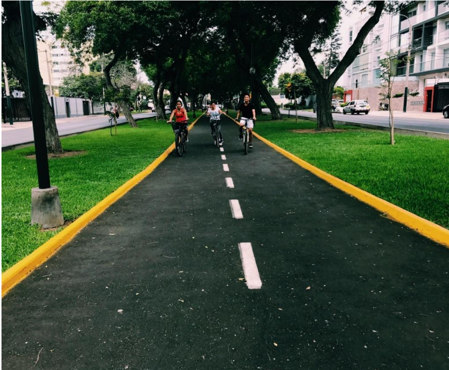
Foto 1: Ejemplo de ciclovía segregada (Avenida Salaverry)
