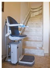
*Figura 4: Salvaescaleras para facilitar la comunicación vertical en un edificio*
