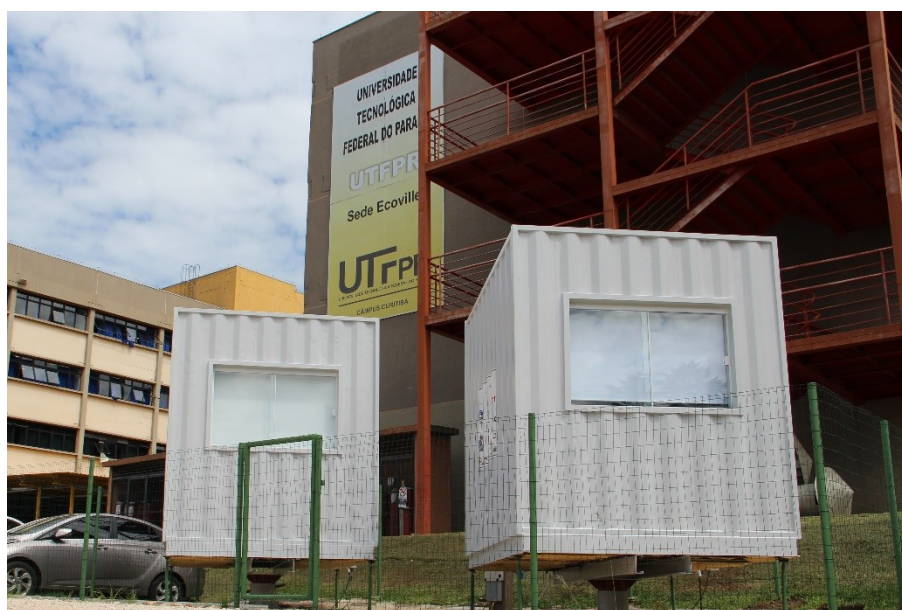
Figura 1: Instalação dos dois módulos da CBBC na UTFPR Sede Ecoville
