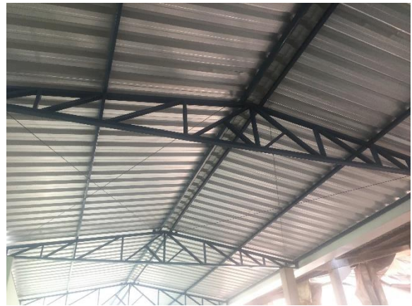
3-Reforma da cobertura
