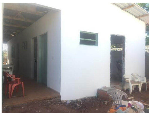
5. Acesso a copa e banheiros novos.
