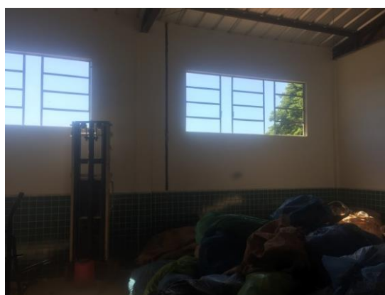
6. Novas janelas, cobertura e pintura.
