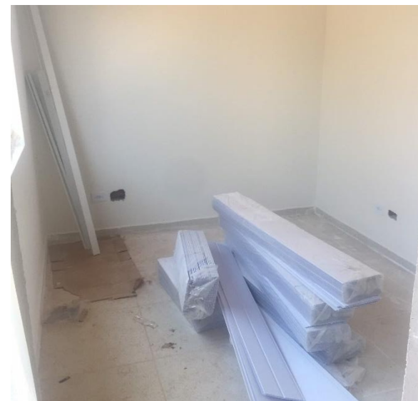
6-Construção área administrativa e banheiros
