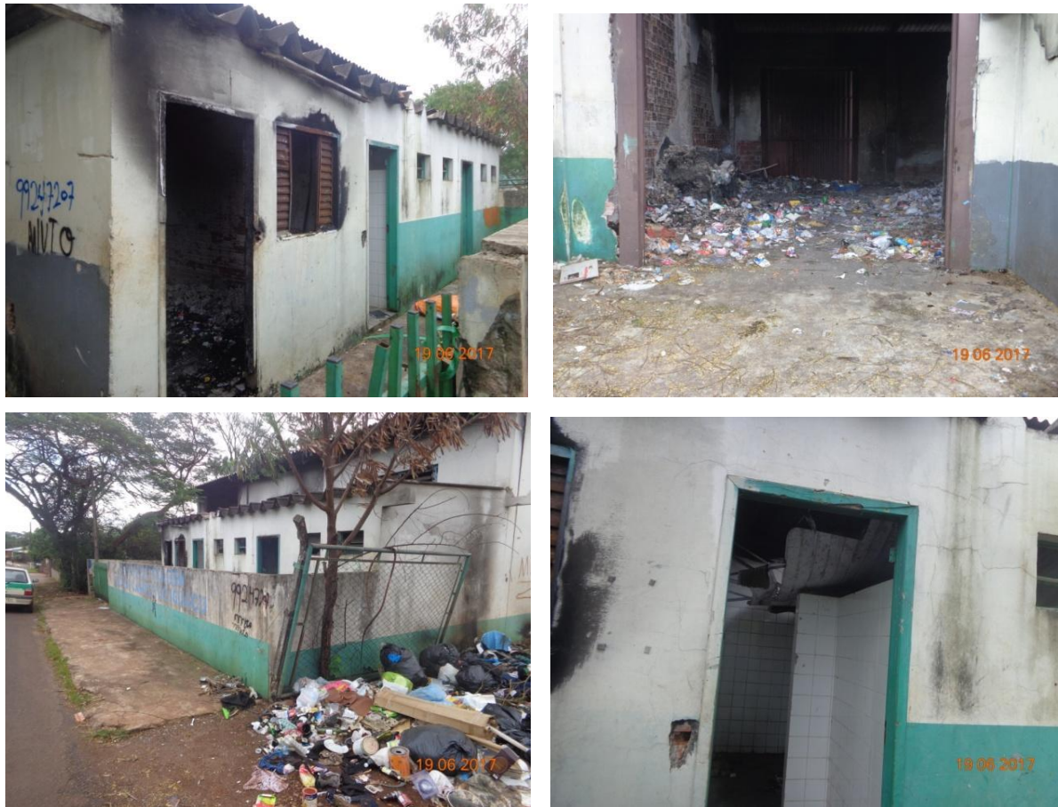
Figura 12. Estado do barracão Campos do Iguaçu, 2017
