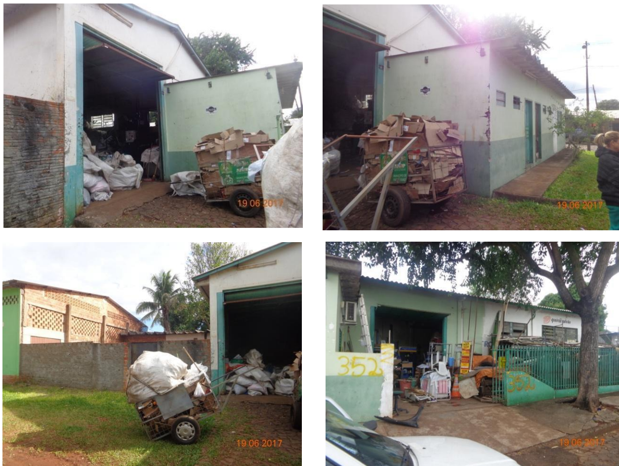
Figura 11. Estado do barracão, Porto Meira 2017.
