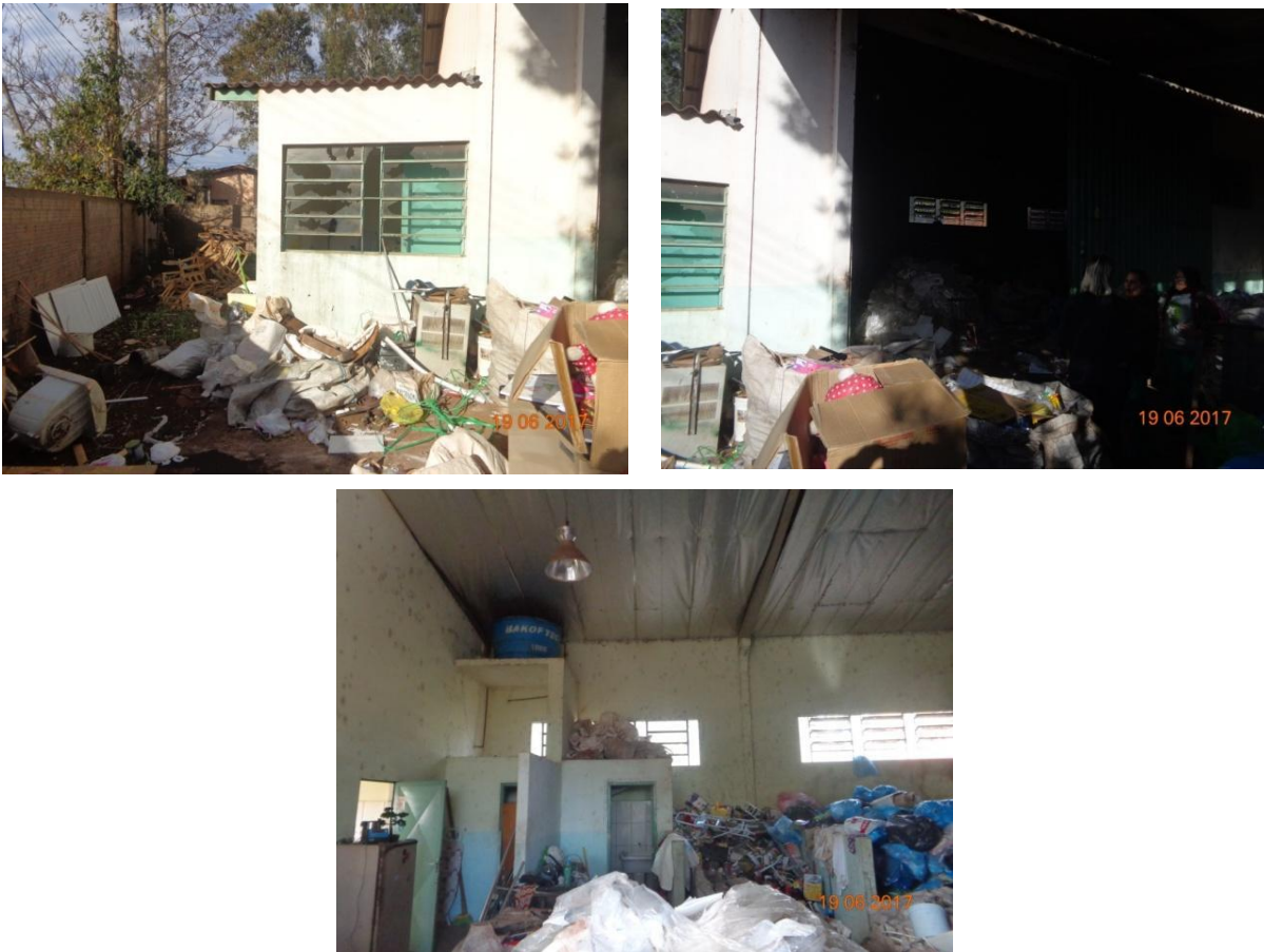
Figura 15. Estado do barracão Três Lagoas, 2017
