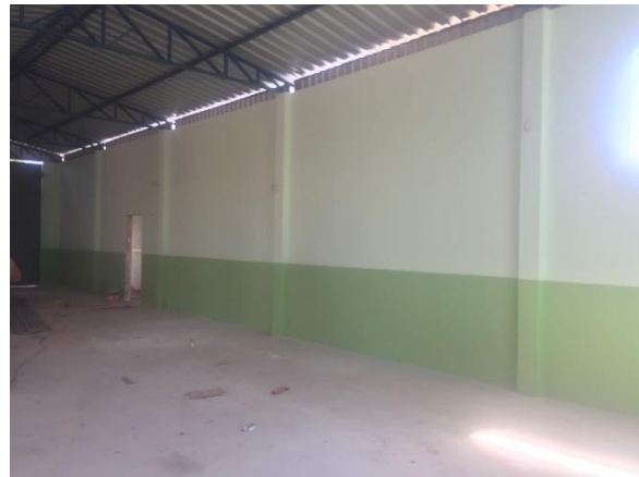
2-Expansão da área do Barracão
