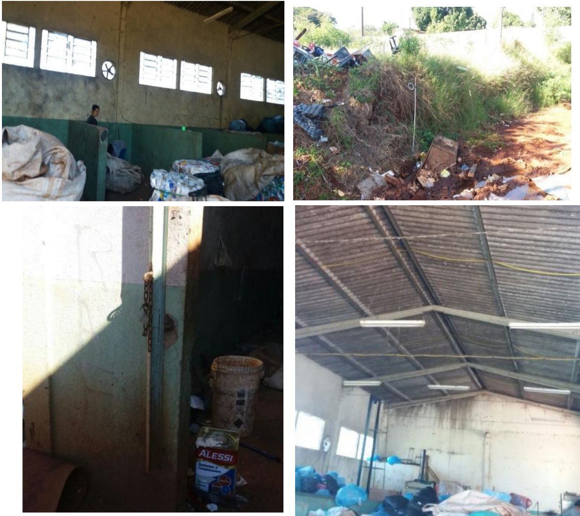
Figura 16. Estado do barracão Vila C, 2017
