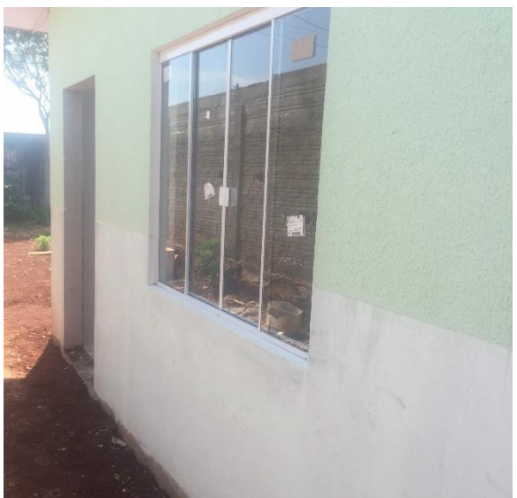
5-Instalação janelas e grade
