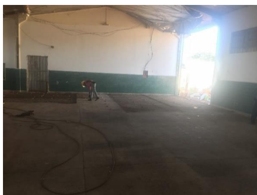
3. Expansão da área do barracão.
