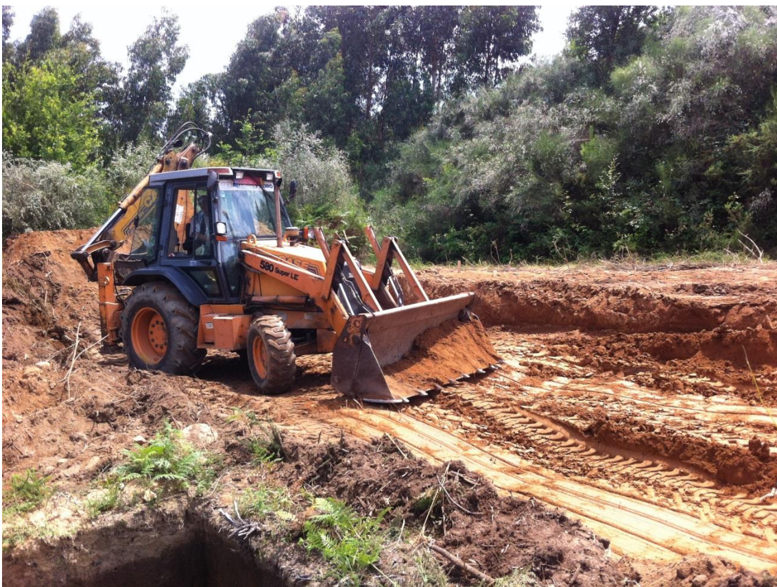
Figura 4 – Retroescavadora utilizada na desmatização e na remoção de um depósito superficial arqueologicamente estéril.
