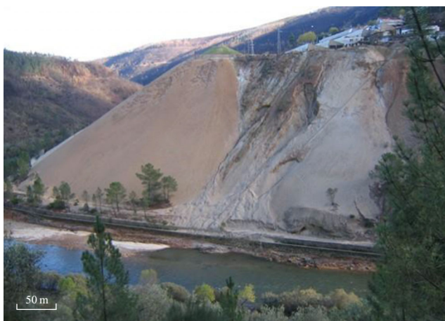
Fig. 2 Slope of the Cabeço do Pião tailings deposit
